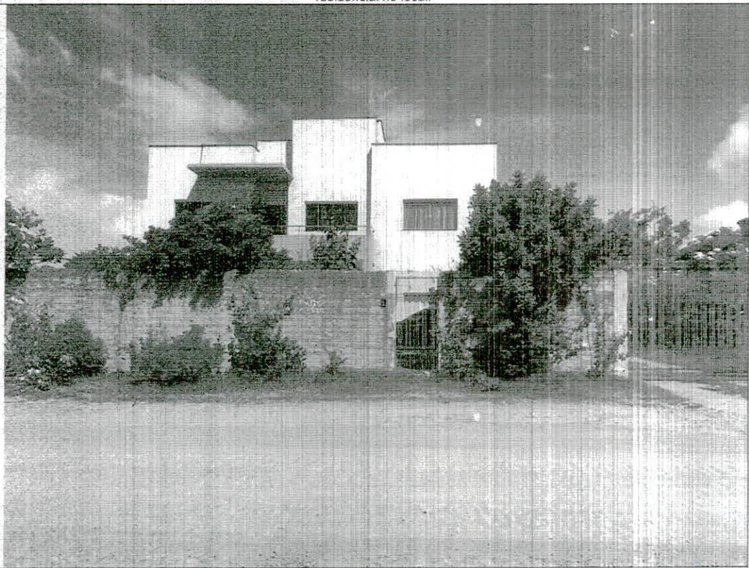
FOTO 3 - Residência na Av. 629 Lote 06 da Quadra 89.
