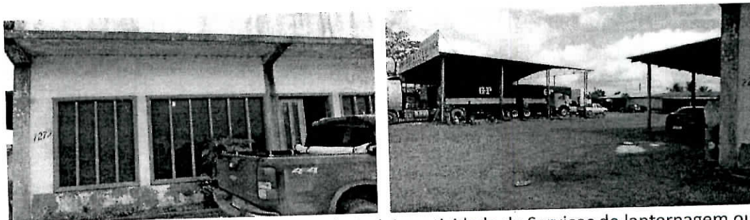
Imagem 01 e 02 – Local onde se pretende incluir a atividade de Serviços de lanternagem ou funilaria e pintura de veículos automotores.
