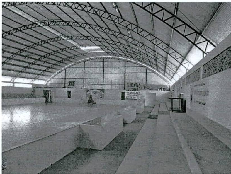
Figura 4 Vista interna – Arquibancada 2
