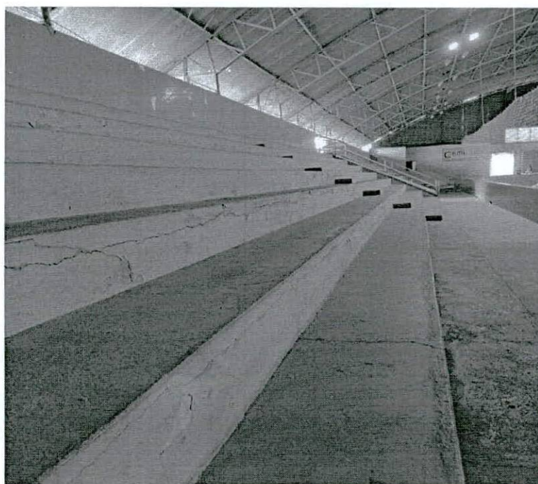
Figura 3 Vista interna – Arquibancada 1
