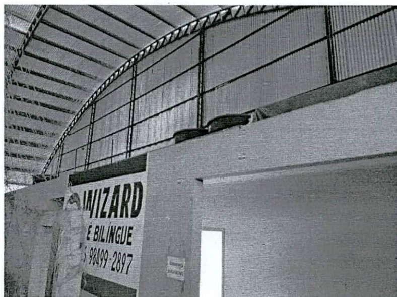
Figura 5 Vista interna – Entrada vestiários
