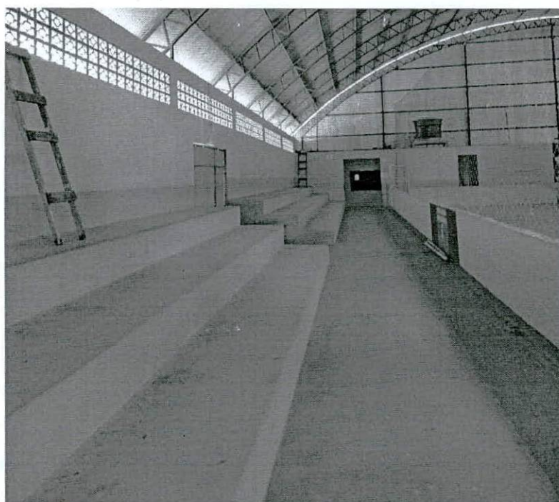
Figura 3 Vista interna – Arquibancada 1
