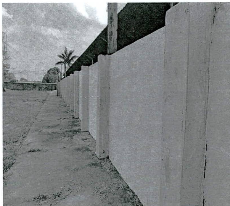
Figura 11 Vista externa – Muro lateral
