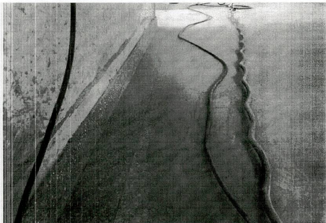
Item executado: Piso Granilite - 13/12/2022
