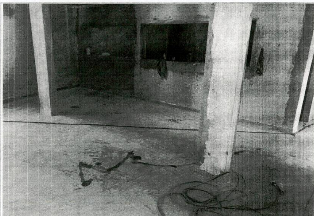
Item executado: Piso Granilite - 13/12/2022
