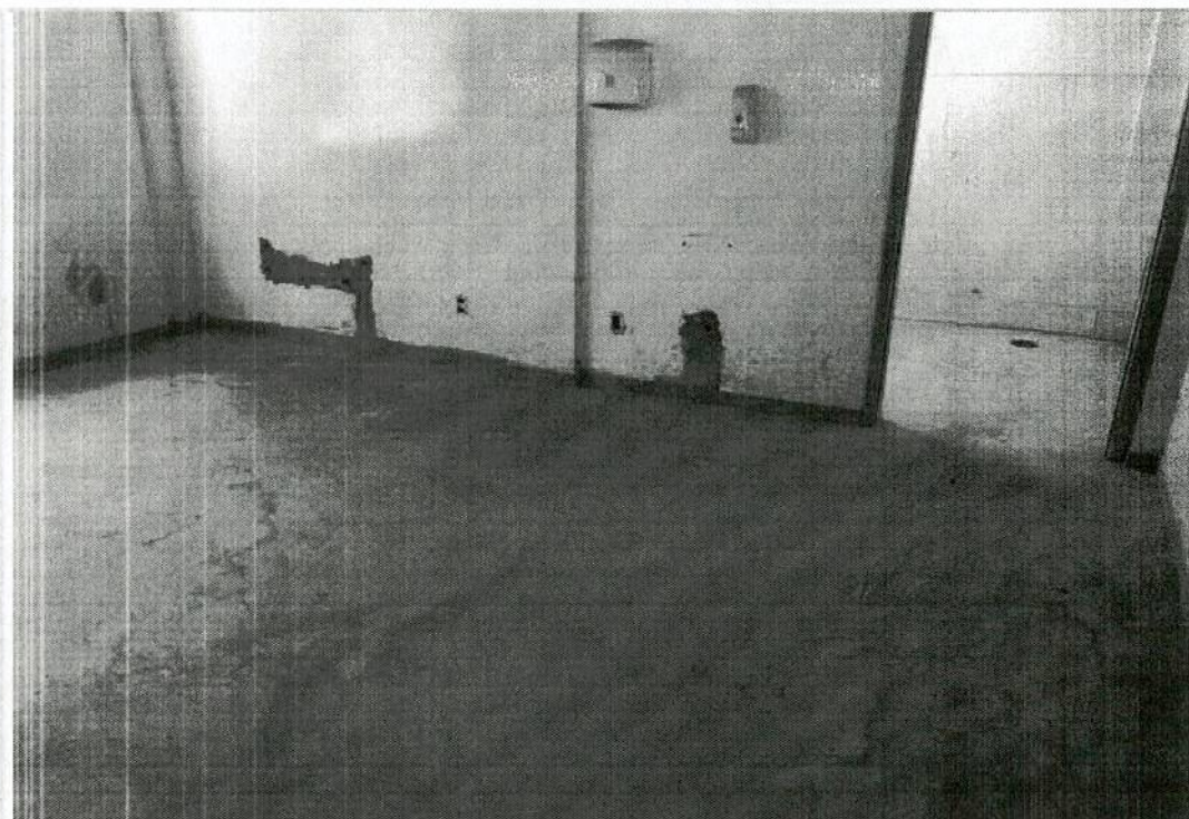
Item executado: Piso Granilite - 13/12/2022
